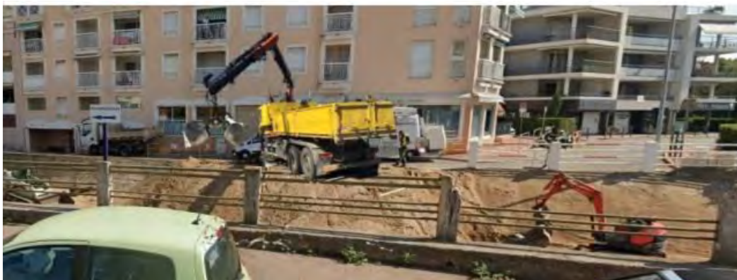
Figure 24 : Chargement des sédiments décantés à la benne dans le camion (source : CMME, 2022)
