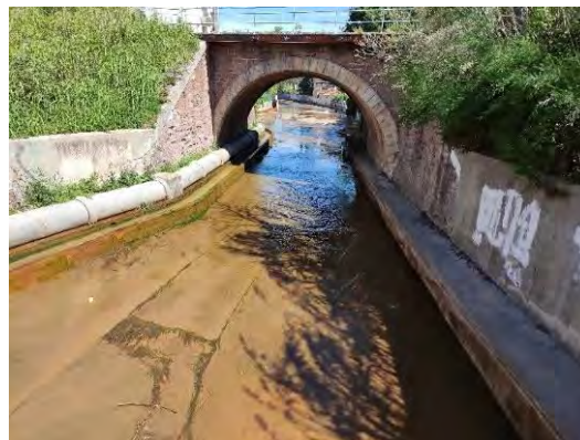
Figure 10 : Pédégat canalisé a niveau du rétrécissement du pont de la voie ferrée (GALATEA, 25/04/22)
