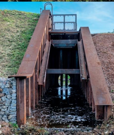
Le pertuis, situé au milieu de la digue, permet à l'eau de s'écouler.
