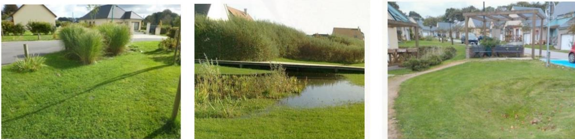
Figure 8-1 : exemple d'ouvrage d'infiltration des eaux pluviales (jardins creux, espaces inondables)
