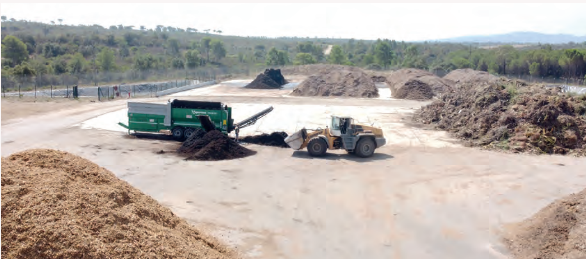
Plateforme de compostage du SMIDDEV à Puget-sur-Argens
