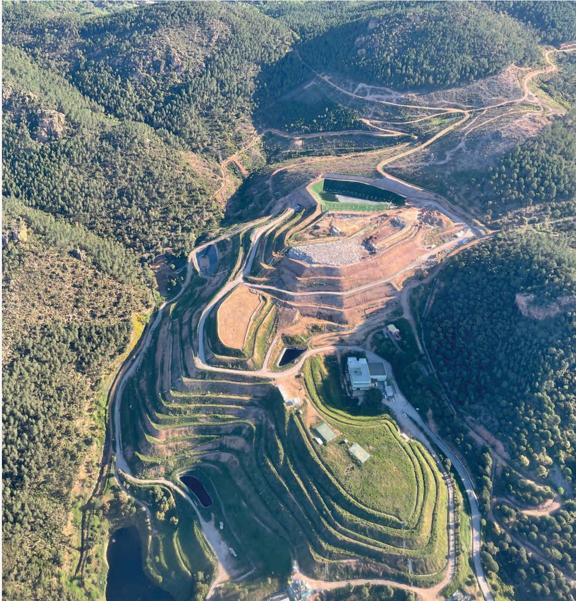
Vue aérienne de l'ISDND – Mai 2021
