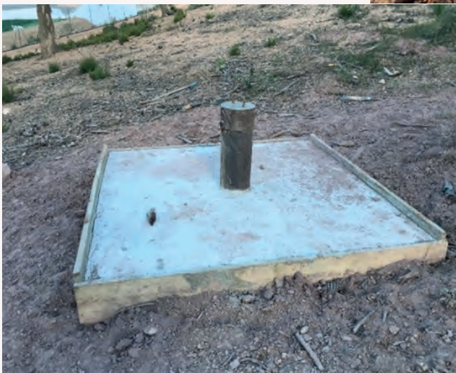
Création de 2 nouveaux piézomètres en amont du site
