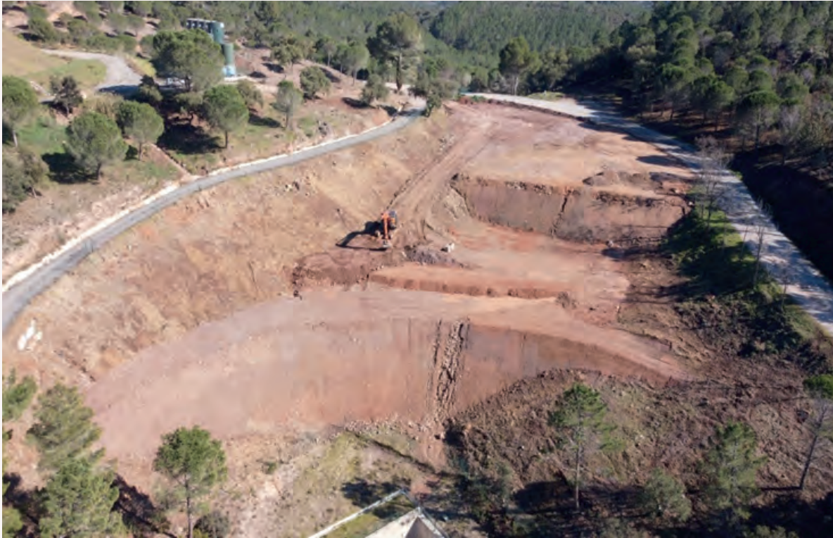
Création d'une plateforme d'accès aux véhicules de défense incendie et de stockage de matériel non dangereux à l'entrée du site
