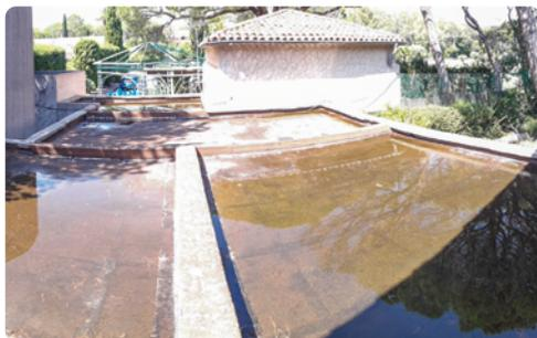
Stagnation d'eau de pluie durable après intempéries sur tout ou parties de la toiture occasionnée par une contre pente, une dépression, résultant d'une malfaçon ou de pissettes surélevées par rapport au niveau de la toiture.
