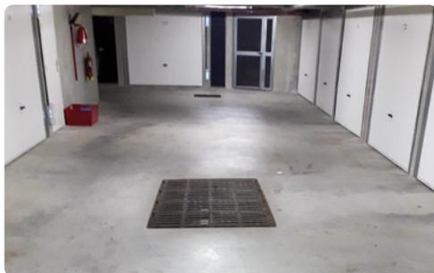
Infiltration des eaux de ruissellement extérieures ou intérieures remplissant le bac destiné à recueillir les huiles ou hydrocarbures en cas d'incident.
