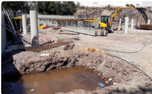
En phase chantier, des eaux stagnantes (intempéries, remontées de nappes...) peuvent s'accumuler en différents points et à différents stades de l'évolution d'un programme d'aménagement: fondations, futur réseau pluvial, bassins de rétention, cages d'ascenseur, garages, déshuileurs, toitures terrasses et terrasses sur plots...
