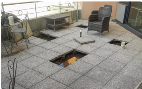
Stagnation d'eau permanente sous les dalles de la terrasse occasionnée par une contre pente et/ou une surélévation de quelques centimètres des exutoires par rapport au niveau de la surface étanchéifiée de l'ouvrage. Accès à l'eau aisé pour les moustiques à travers les écartements de dalles ou les tuyaux d'évacuation.
