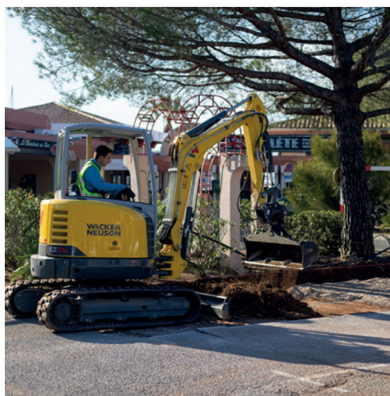
Création d'une place PMR
