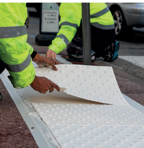
Pose de bandes podotactiles
