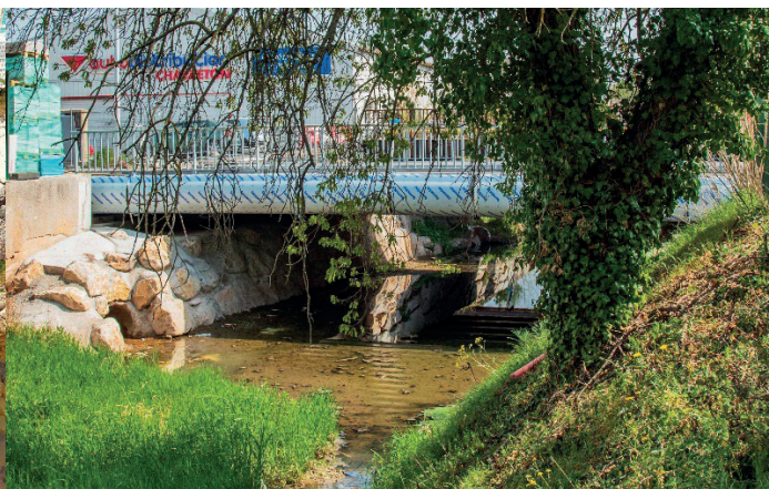
Le nouveau pont de la Garonnette.
