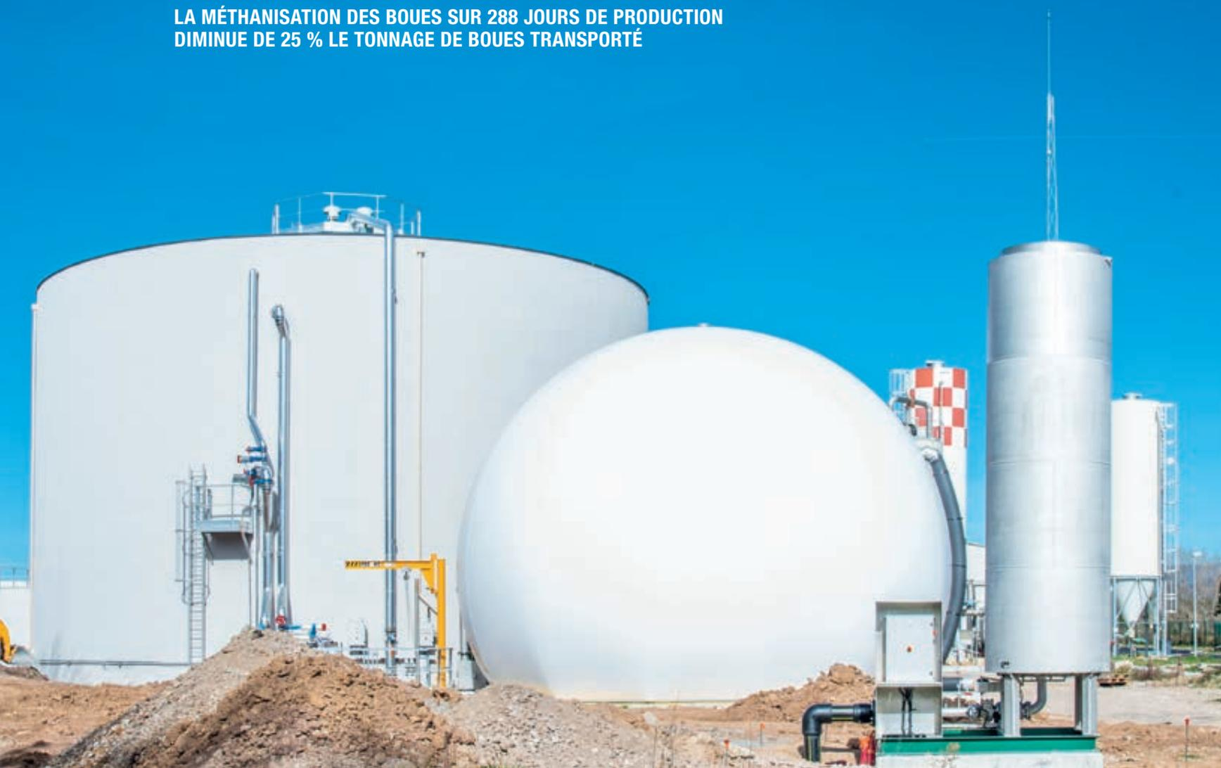
Vue du digesteur de la STEP du REYRAN qui permet de transformer les boues en biogaz.
