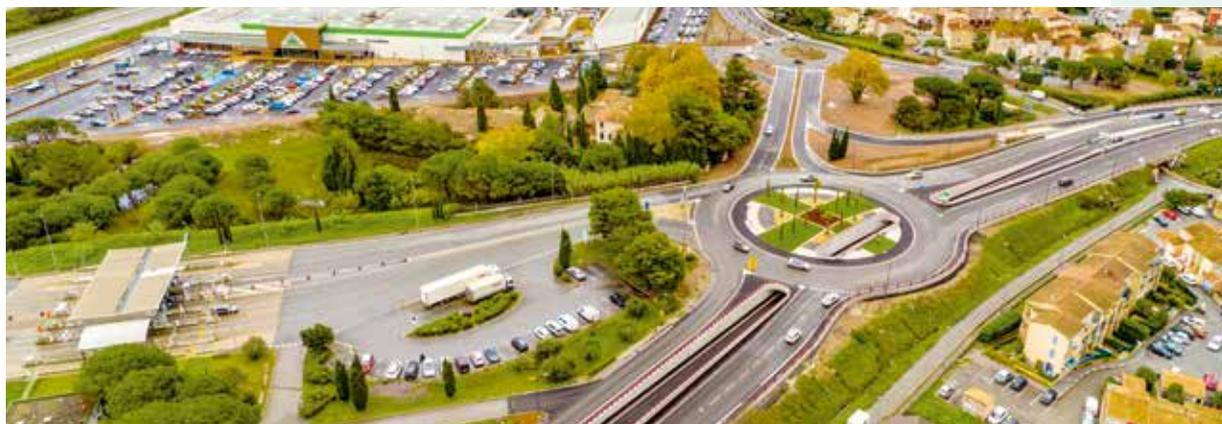
Après treize mois de travaux, le passage souterrain sous le rond-point de l'autoroute A8 sur la RDN 7 Fréjus-Le Muy a été mis en service fin octobre 2018. Cet ouvrage de grande envergure avec un tunnel de 230 mètres de long possède un bassin de rétention de 165 m<sup>3</sup>, un puits de lumière de 22,7 mètres de profondeur et un giratoire de 30 mètres de rayon.
