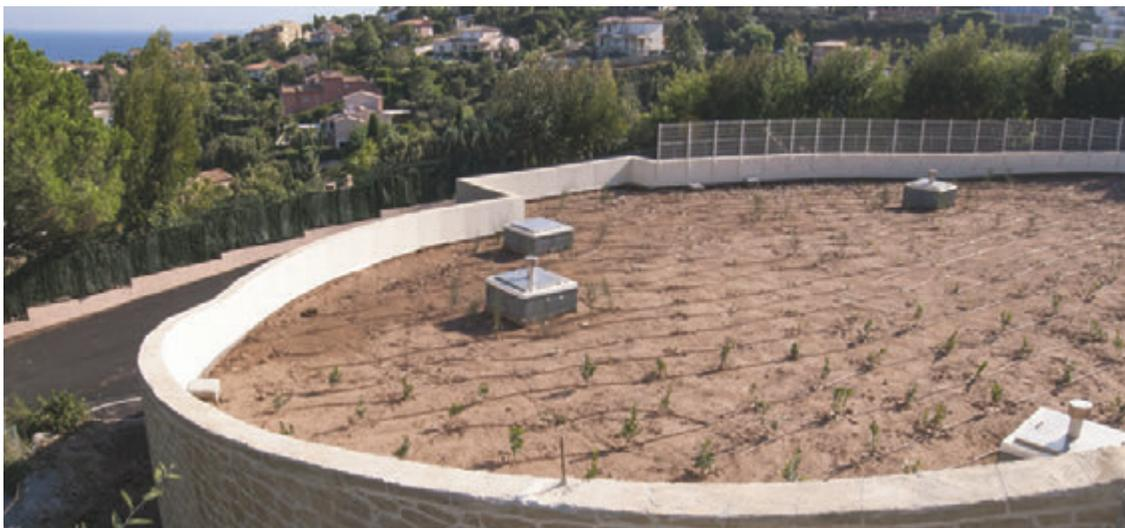
Bâti dans le site classé de l'Estérel, après avoir démontré la nécessité de son extension dans cette zone naturelle où sa situation en hauteur à proximité de l'usine de potabilisation garantit un remplissage direct ainsi qu'une pression adaptée à la distribution de l'eau, le réservoir est aujourd'hui projeté en encastrement dans la colline avec une architecture qui permet la reconstitution des terrasses existantes et la transparence de l'édifice dans le site.
