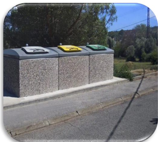
Les colonnes semi enterrées
